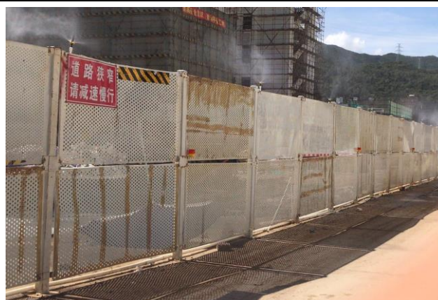
施工围栏及洒水降沉
