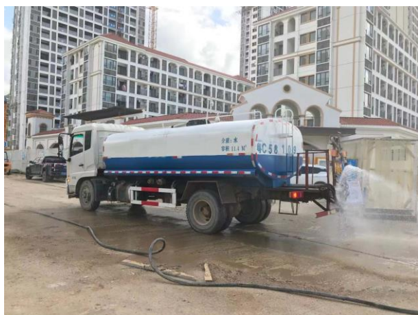
施工期洒水降尘
