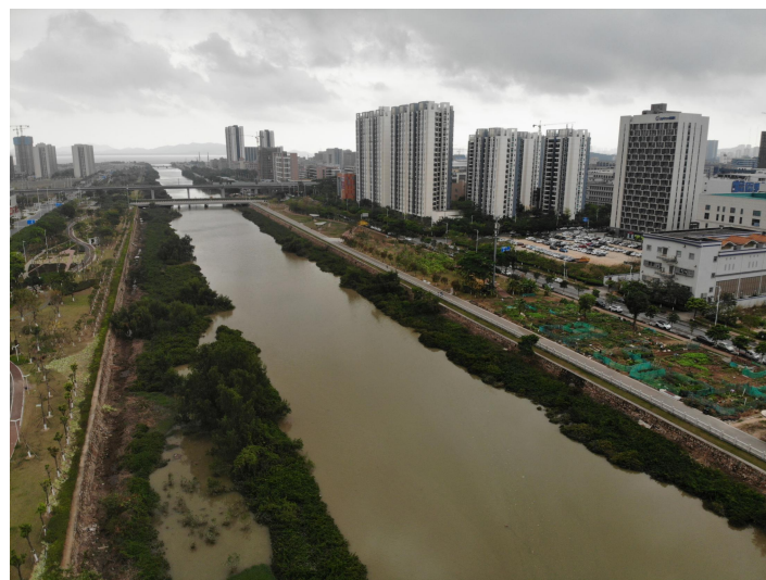
东西两侧中珠排洪渠
