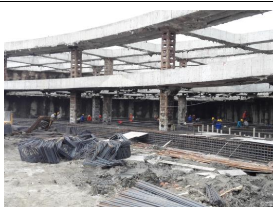
图 10：第三道支撑梁施工
