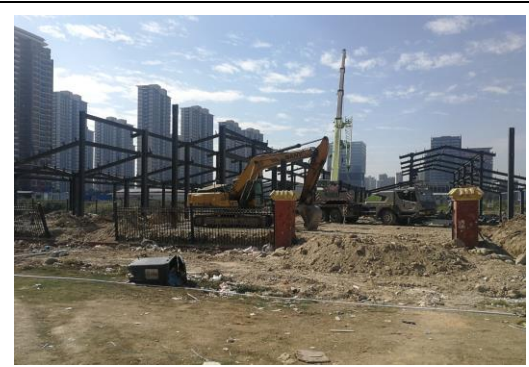
图 22: 临建区现阶段使用现状
