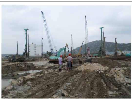
图 2：第一道支撑梁施工
