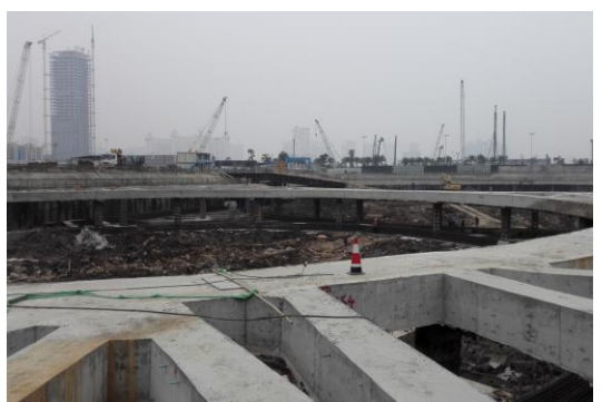
图 6：第一道支撑梁施工（二）
