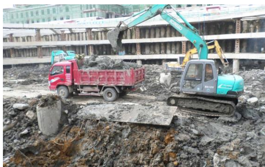
图 11：第四层土方开挖
