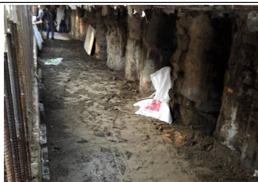
图 16：地下室外墙回填施工（二）
