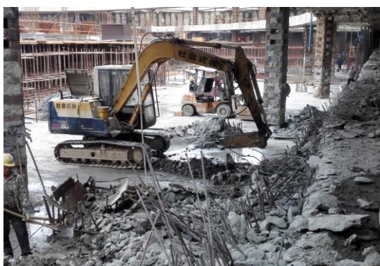
图 13：支撑结构接卸拆除施工（一）
