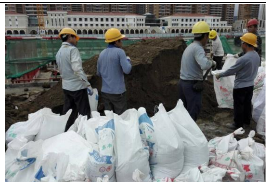
图 15：地下室外墙回填施工（一）
