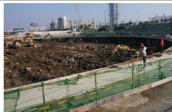
图 7：第二层土方开挖
