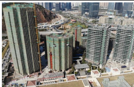
图 21: 早期堆土区现阶段施工现状
