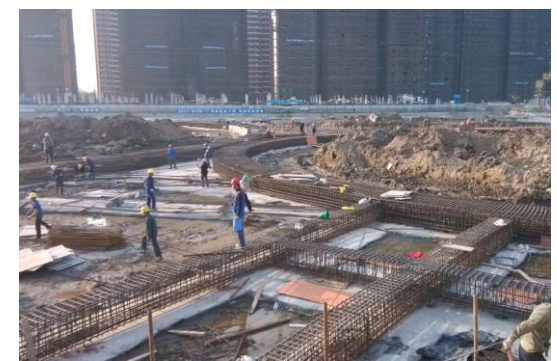
图 5：第一道支撑梁施工（一）
