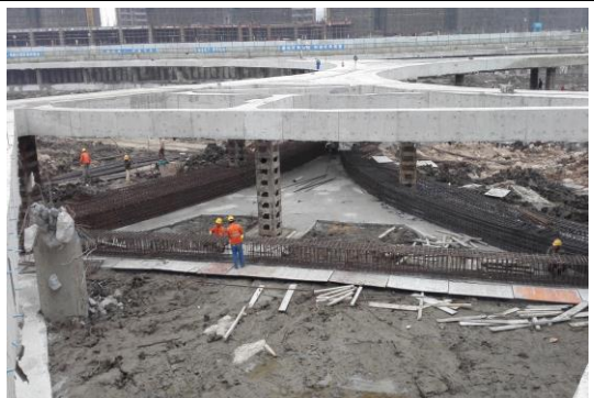
图 8：第二道支撑梁施工
