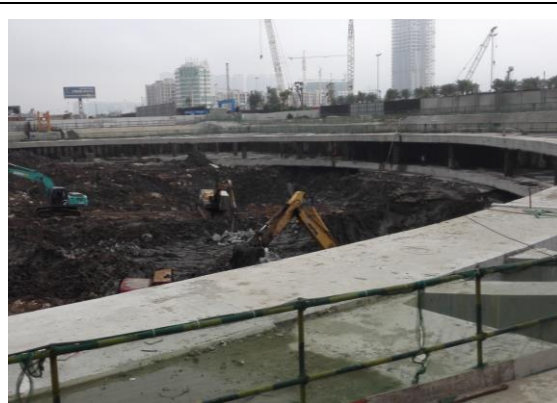
图 9：第三层土方开挖
