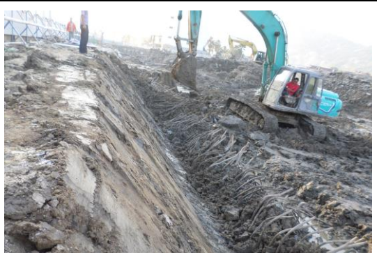
图 4：第一层土方开挖（二）
