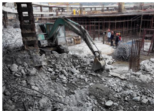
图 14：支撑结构接卸拆除施工（二）
