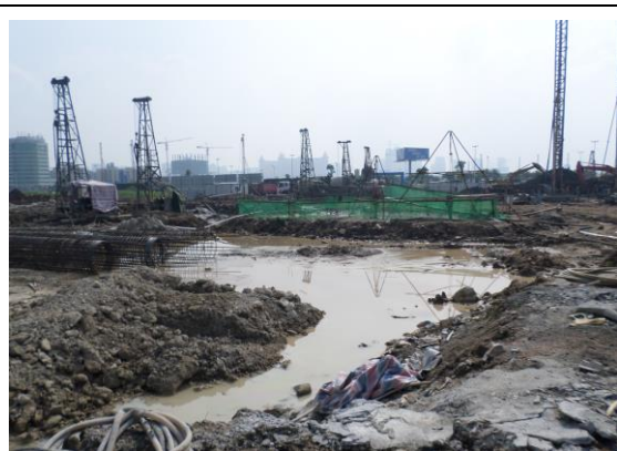
图 1：支护桩施工
