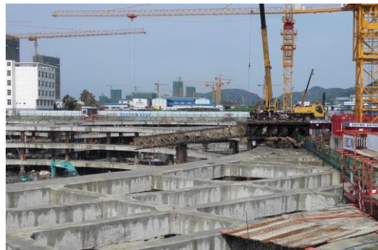
图 12：支护栈桥拆除施工
