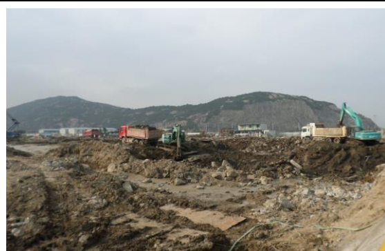
图 3：第一层土方开挖（一）
