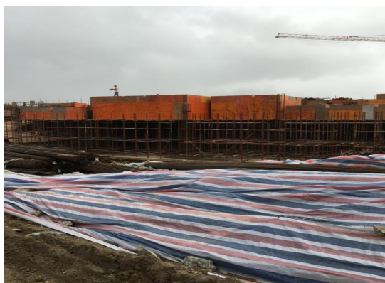
彩条布覆盖（施工期）
