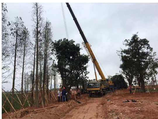
管道施工（施工期）
