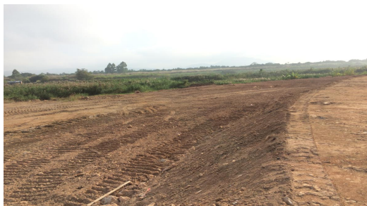
场地中部（施工前）
