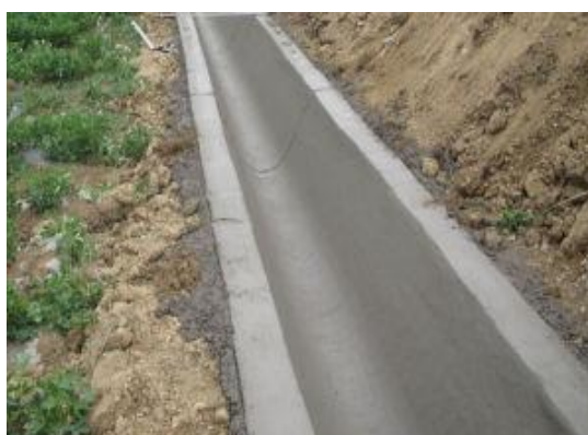
临时排水沟（施工期）
