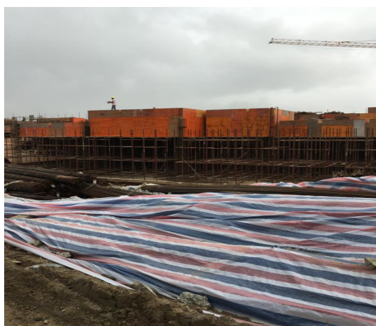
彩条布覆盖 (施工期)
