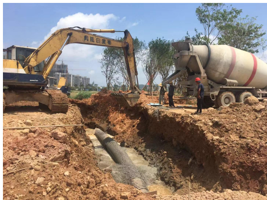
管道施工（施工期）
