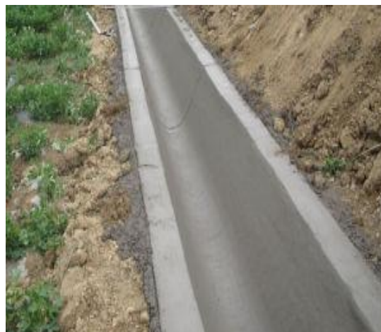
临时排水沟 (施工期)
