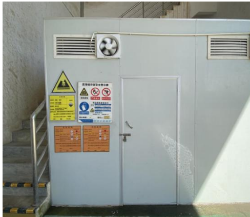
危险废物暂存间
